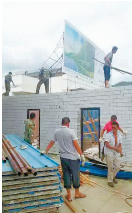
图为区域建综治办组织城管、仁和镇对违章建筑进行拆除。
