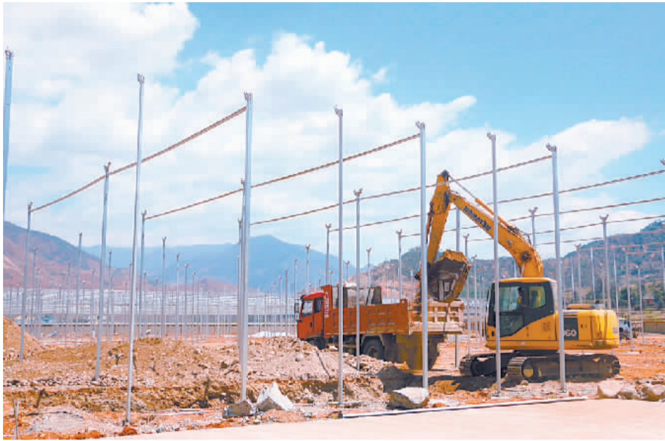
6月7日,位于米易县白马镇的红旗河坝花卉产业园项目建设现场。
