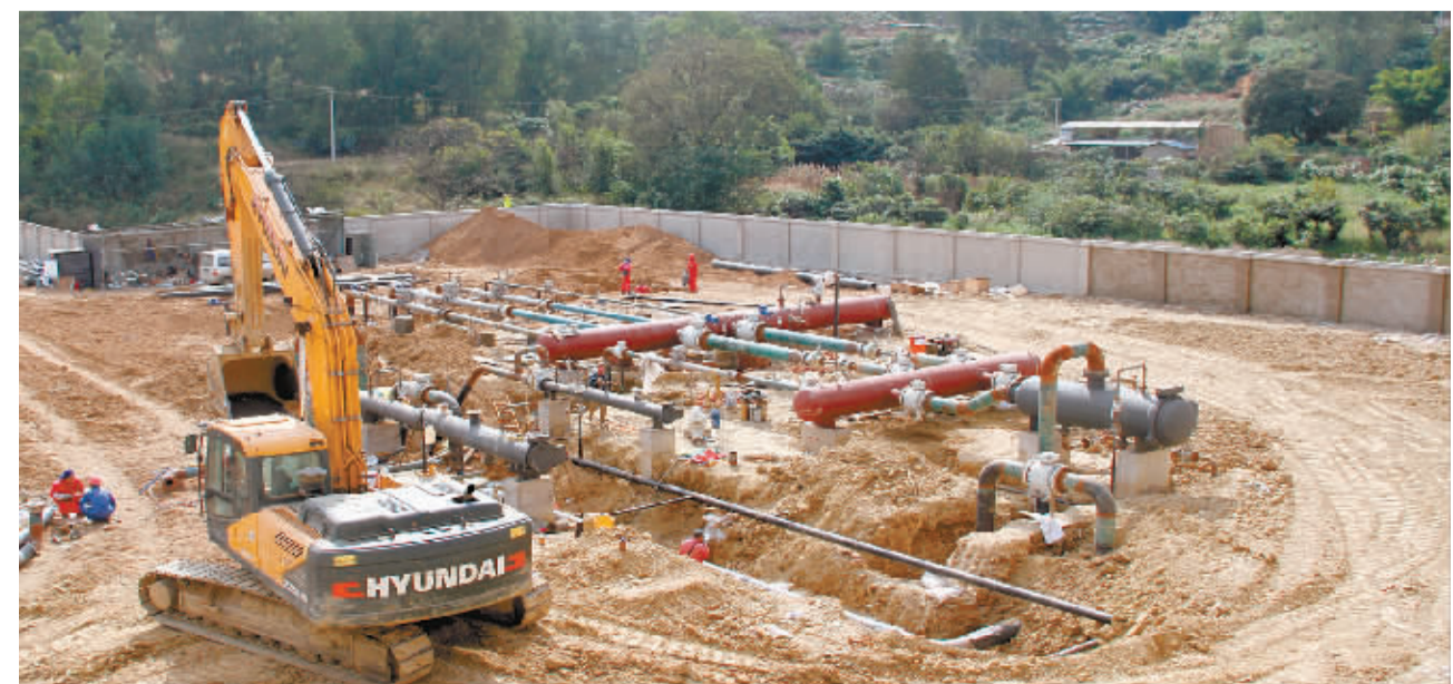
钒钛高新区配气站建设现场。
